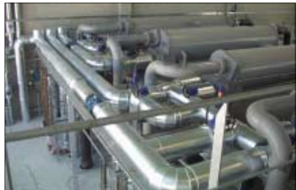
4 Stück Absorptionskältemaschinen Rohrleitungsanschlüsse kühl-, kalt- und heißwasserseitig
