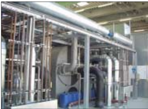
4 Stück Absorptionskältemaschinen Rohrleitungsanschlüsse kühl-, kalt- und heißwasserseitig
