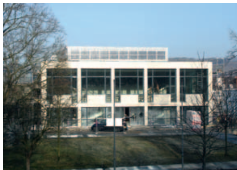
Fassade nach der Sanierung
