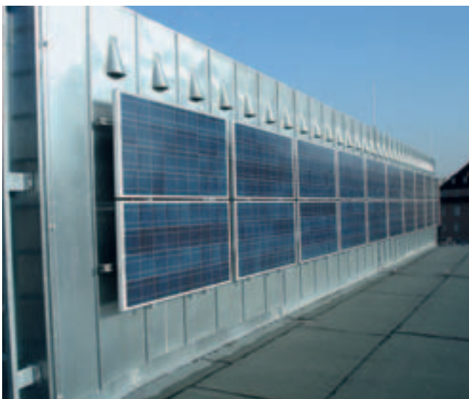
Dachaufbauten mit Fotovoltaik
