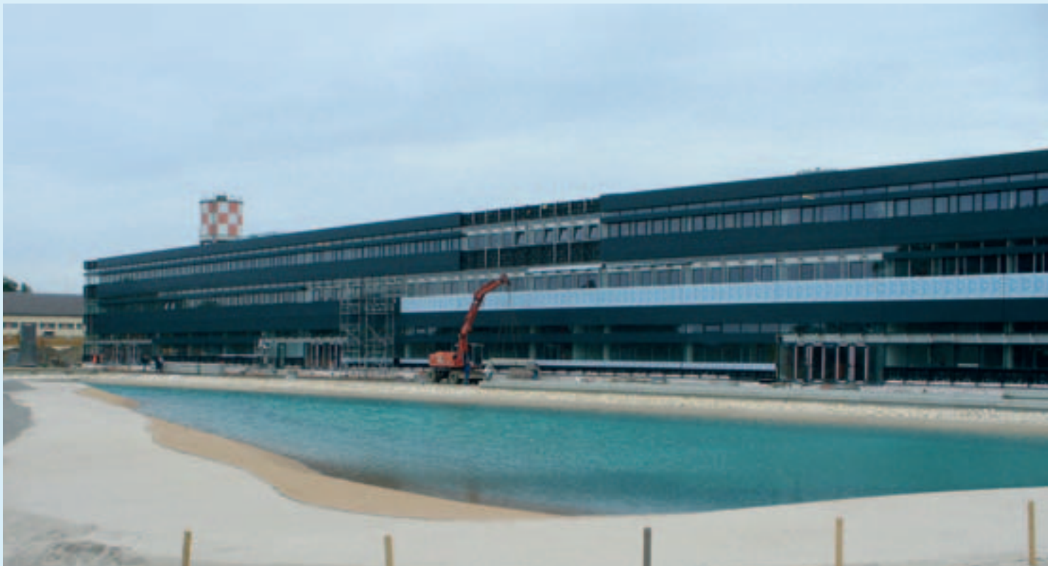
Foto der Baustelle
