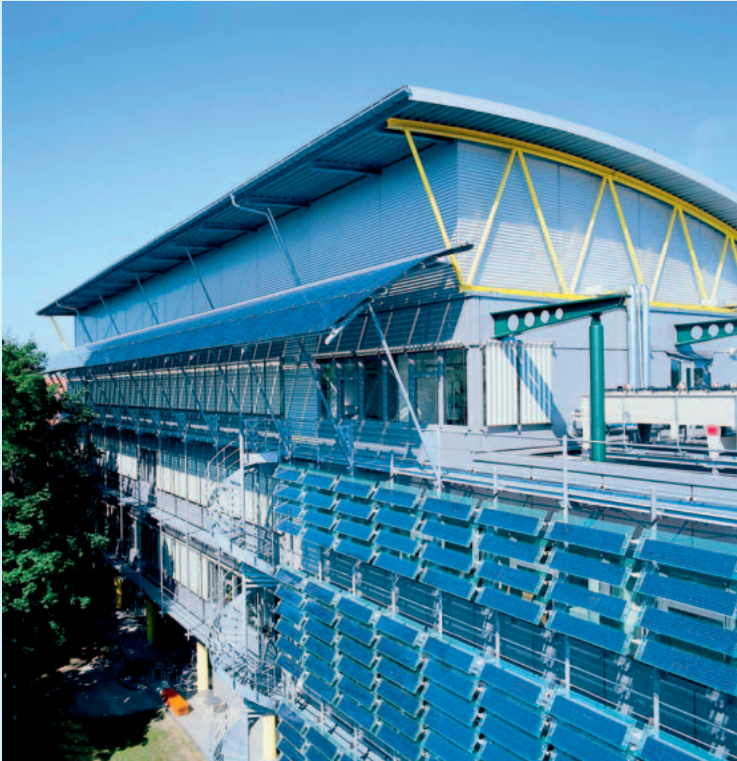
Fotovoltaikanlage, Nikolaus-Fiebiger-Zentrum, Universität Erlangen-Nürnberg
