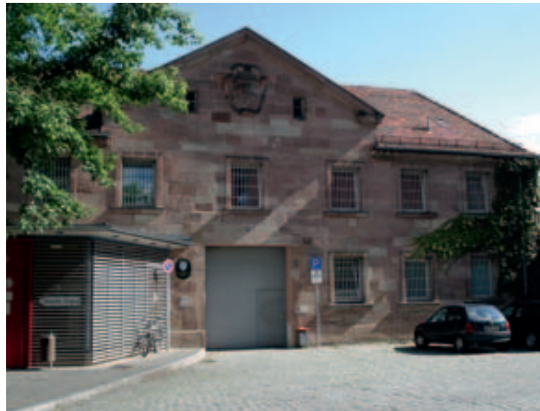
Eingangssituation JVA Nürnberg
